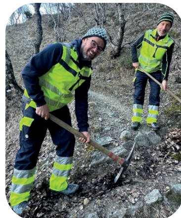
Amade Roten u. Martin Squaratti bei Unterhaltsarbeiten
